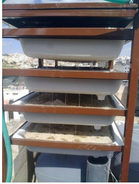
وحدة إعادة تدوير المياه الرمادية
